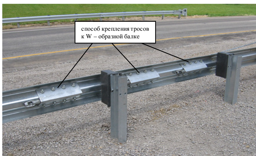
Рисунок 6 – Пример сопряжения профильного ограждения с тросовым
