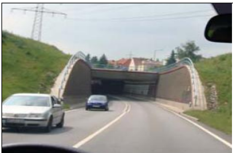
Рисунок 8.3 - Тоннели с полной изоляцией прилегающей территории от транспортного шума (а, б) и с использованием пространства над тоннелем для местного движения (в, г)
