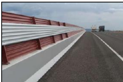
Рисунок 7.5 - Зрительное уменьшение высоты экрана за счет добавлением продольных элементов
