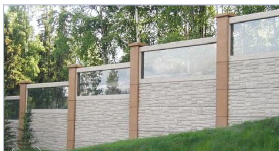
Рисунок 7.10 - Расположение шумозащитного экрана из панелей одинаковой высоты на участке дороги с продольным уклоном
