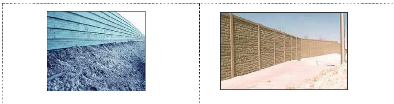
Рисунок 6.40 - Временное размещение снега у шумозащитного экрана в зимний период
