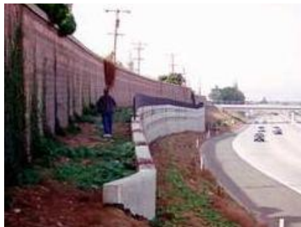
Рисунок 6.68 - Комбинированное шумозащитное сооружения «грунтовый вал – экран– подпорная стенка» со стороны источника шума
