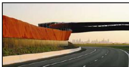
Рисунок 7.6 - Волнообразный верх экран зрительно уменьшает его высоту
