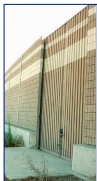
Рисунок 6.35 - Пожарный проход в шумозащитном экране
