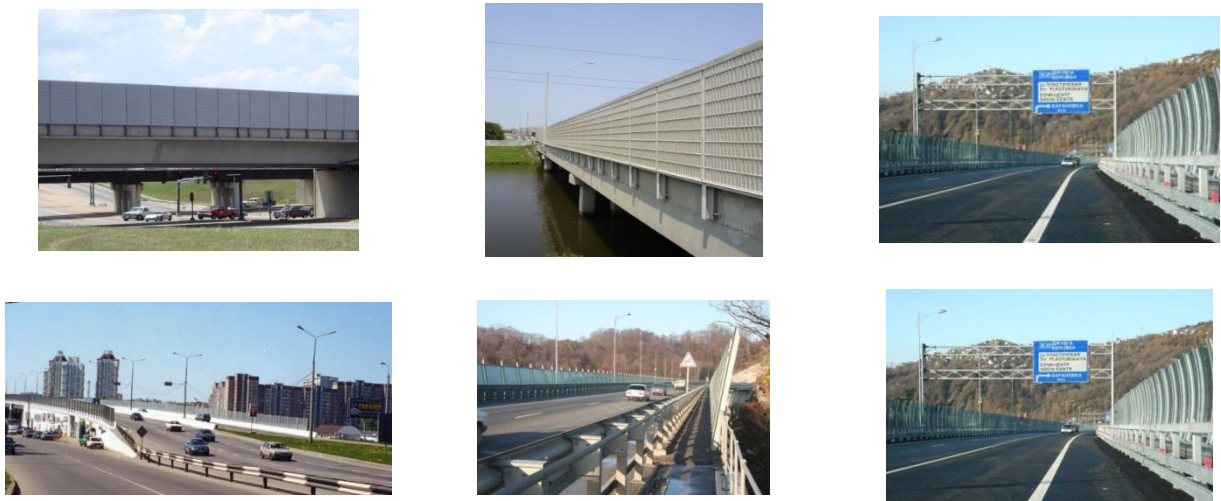
Рисунок 6.46 - Расположение шумозащитного экрана на мостах и путепроводах
