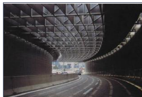
Рисунок 8.2 - Естественное освещение и проветривание шумозащитной галереи
