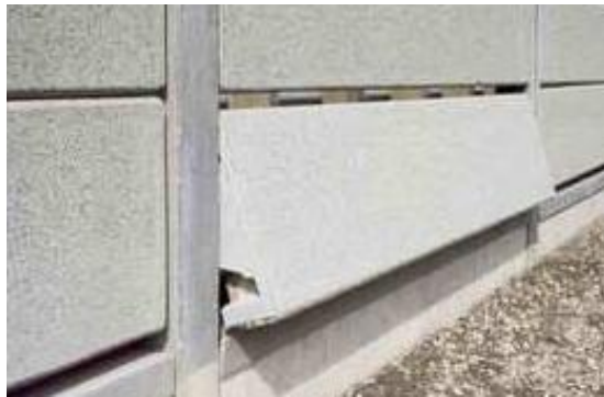
Рисунок 6.45 - Подвешенная нижняя панель экрана для отвода воды с проезжей части
