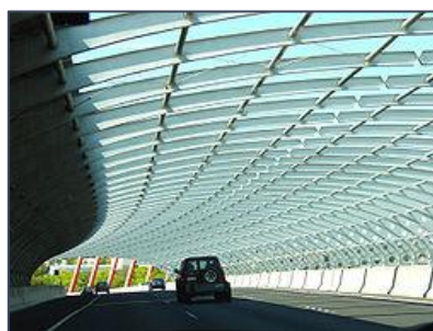
Рисунок 8.2 - Естественное освещение и проветривание шумозащитной галереи
