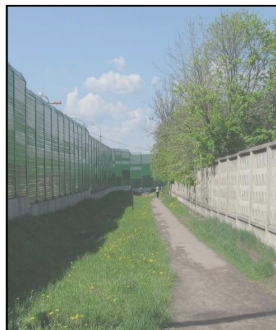
Рисунок 7.3 - Высокий шумозащитный экран создающий «тоннельный эффект» со стороны дороги и «эффект тюрьмы» со стороны застройки
