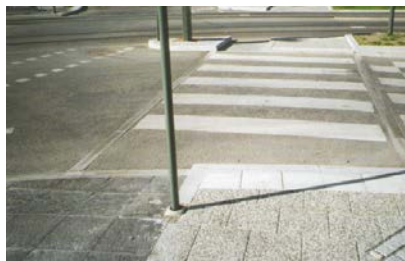
Рисунок 24– Пример выполнения пандусов по краю пешеходного перехода
