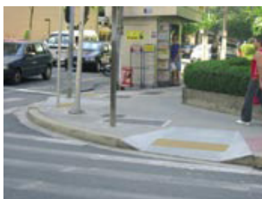
Рисунок 20 – Пример пандуса со скошенными боковыми гранями
