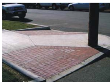
Рисунок 22 – Пример пандусов с бортиками
